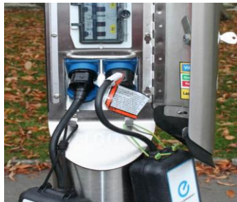
Fig 3 - Mode 2 ladeboks Schuko med kroker for oppheng av ladeboks
