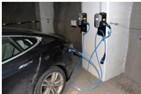
Fig 6 - Mode 3 på vegg lader med Type 2 kontakt
