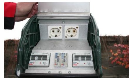
Fig 9 - Mode 2 Schuko -varmgang i eksisterende kontakt ved 16A
